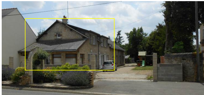
Figure 3 : Vue du site – habitation (Juillet 2014)
